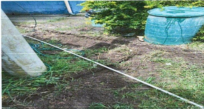
Foto 2: Reparación de drenaje y agua potable.
