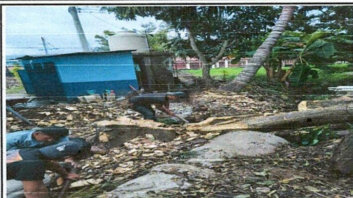
Foto1: Reparación de muro perimetral y destronque de árboles, que están dañando muro y dirección de establecimiento.
